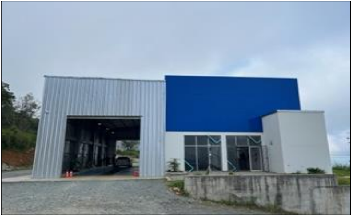
Edificio ubicado en la av. Boanerges Pereira y Héctor Romero
