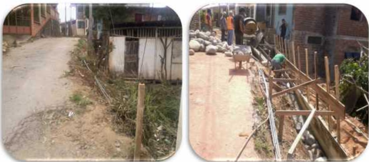
Construcción de muro, bordillos y cunetas en la calle "Belisario Narea"
