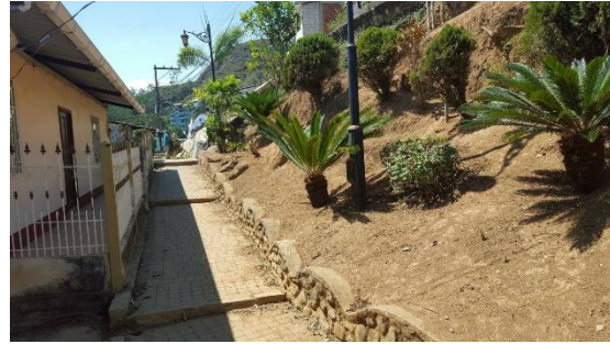
Limpieza de malezas sector La Protectora
